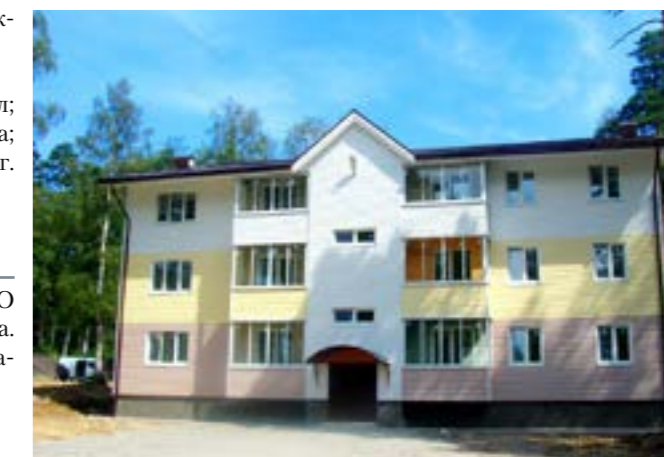
Строительство квартала ЖК «Сосновая горка» организацией-партнером СРО «СФЕРА-А» ООО НПКФ «ОРТИС»
