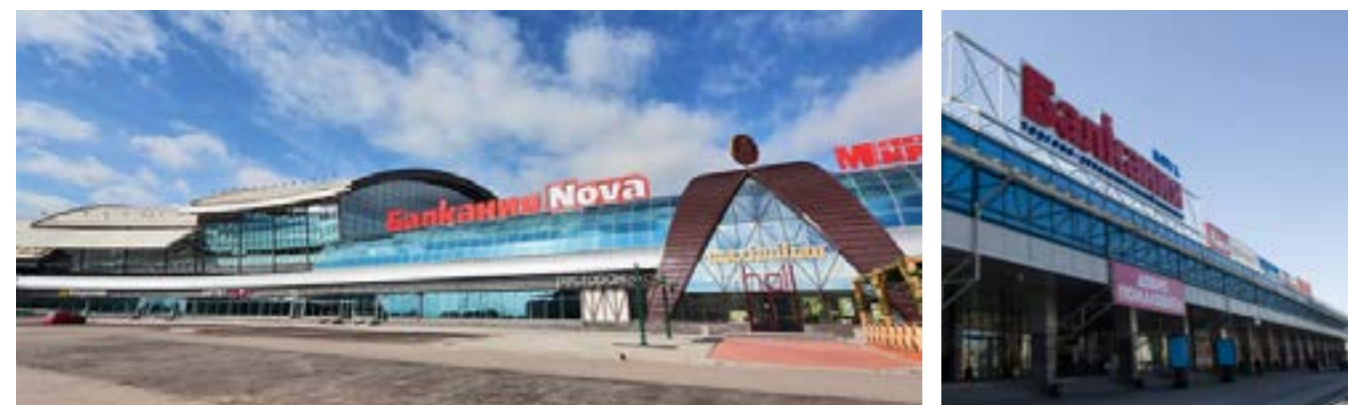
Работы по электроснабжению произведены компанией-участником НП «УСПП» ООО «Балтэлектромонтаж-300»
