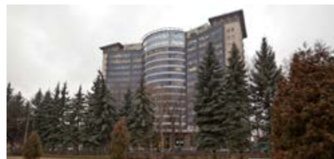
Проектирование и монтаж электрических и слаботочных сетей, а так же проведение электроизмерительных испытаний на площадях Биржевого комплекса в г. Санкт-Петербург.
