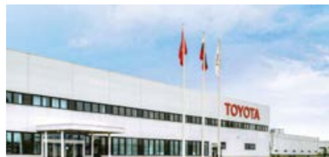
Монтаж электрических и слаботочных сетей на объекте: завод «Тойота» Шушары.
