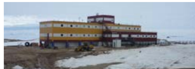
Член НП «СРО «ОПСР» ЗАО «НТК «Аэротехнический центр» ведет строительство нового зимовочного комплекса со снежно-ледовой взлетно-посадочной полосой на российской антарктической станции «Прогресс» (Антарктида, 2013 год)
