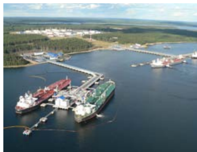
Портовые сооружения Балтийской трубопроводной системы. ОАО трест «Севзапморгидрострой»
